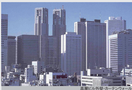
高層ビル外壁・カーテンウォール
