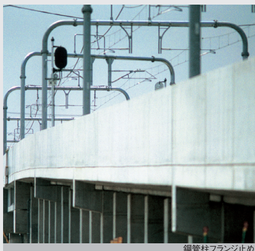
鋼管柱フランジ止め
