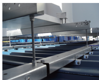
◀ 栈橋部 カバープレート締結
