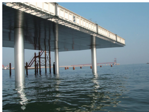
◀ 栈橋部 カバープレート締結
