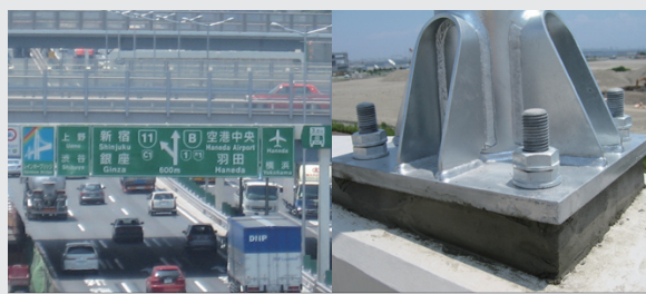
照明柱アンカー部 (首都高速道路)
