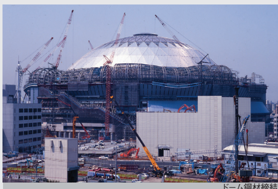
ドーム鋼材締結
