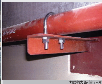
施設内配管止め
