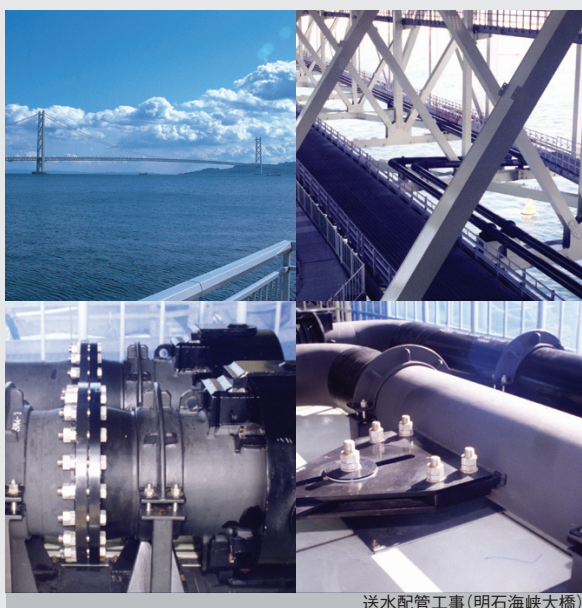
送水配管工事(明石海峡大橋)
